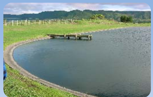
XỬ LÝ NƯỚC AO HỒ SINH THÁI
