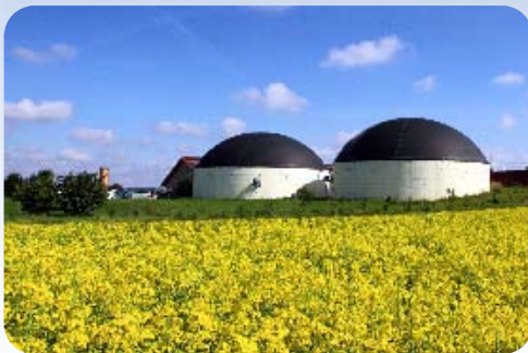
XỬ LÝ BÙN THẢI BIOGAS
